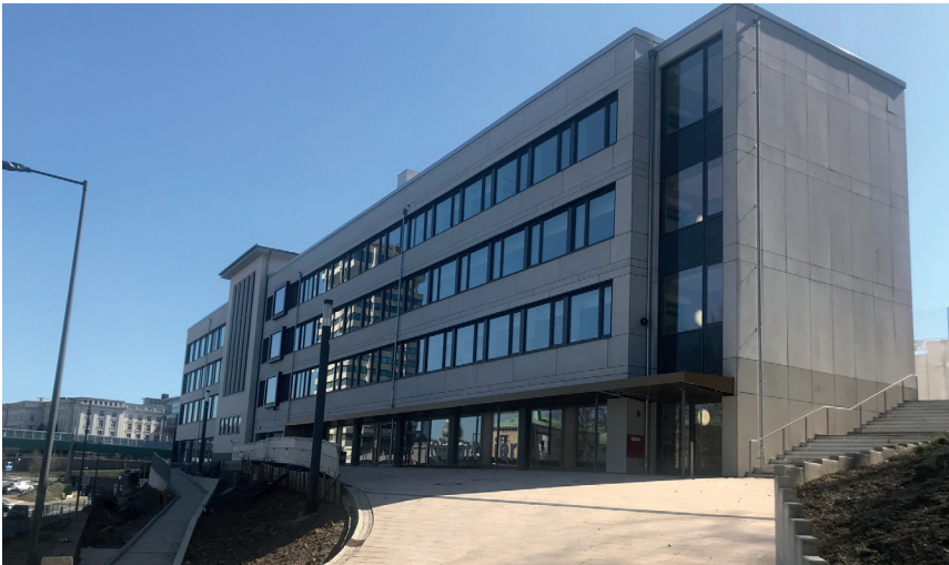
Zugang zum Mehrzweckraum im UG des WDG von der Südstraße
